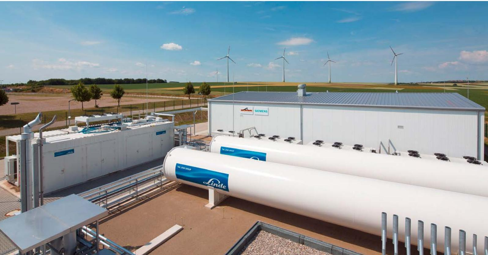
Im Projekt Energiepark Mainz hat ein Forschungsverbund einen leistungsstarken Wasserstoffelektrolyseur entwickelt – die Anlage ist mit bis zu 6 Megawatt Stromaufnahme die weltweit größte ihrer Art.
