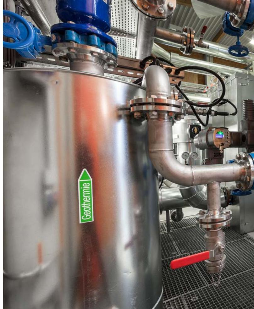
Das Wasser aus einer Förderbohrung wird durch Leitungen in ein Geothermieheizkraftwerk geleitet.
