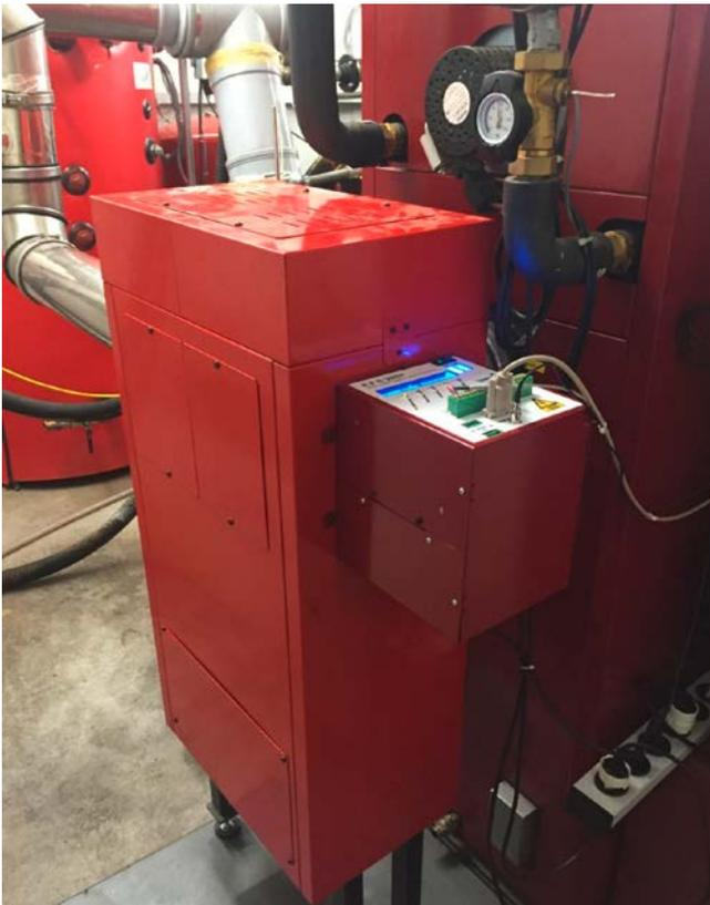
Im Projekt IntEleKt entwickeln Forscherinnen und Forscher einen integrierten Elektrofilter in einem Kleinserientest weiter.
