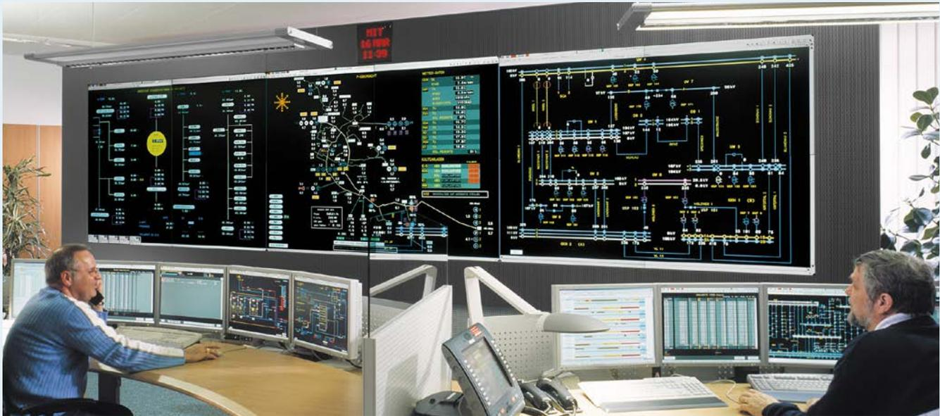
Im Projekt NetzDatenStrom geht es – wie hier in der Leitwarte der MVV Netze GmbH – um einen sicheren und effizienten Umgang mit der enormen Menge und Vielfalt an Daten, die aufgrund des automatisierten Erfassens von Messwerten entsteht.
