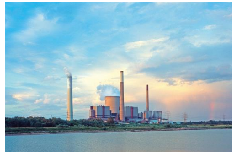
Kraftwerk Voerde. Quelle: STEAG
