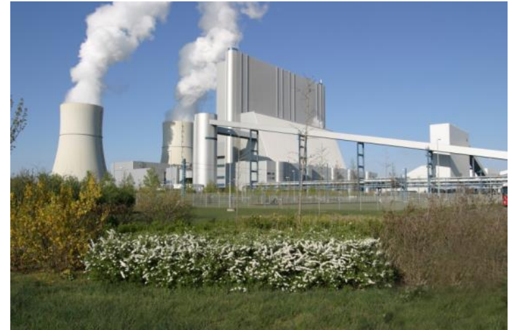
Kraftwerk Schwarze Pumpe. Quelle: Vattenfall
